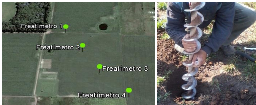
Figura 2. Ubicación e instalación de los freáticos
